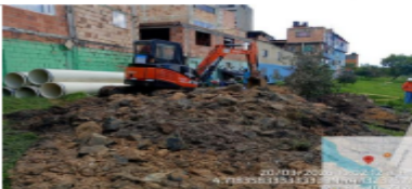
Fotografía No. 5 Intervención operativa de la EAAB – Zona 2 en la RDHJA
