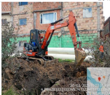
Fotografía No. 3 Excavación de Zanja en la RDHJA con maquinaria pesada
