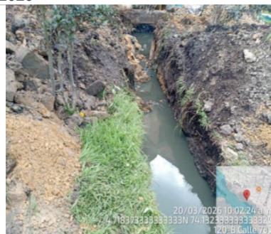
Fotografía No. 4 Apertura de zanja e ingreso de aguas residuales ala RDHJA
