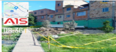
Fotografía No. 10 Área demarcada con cinta de peligro
